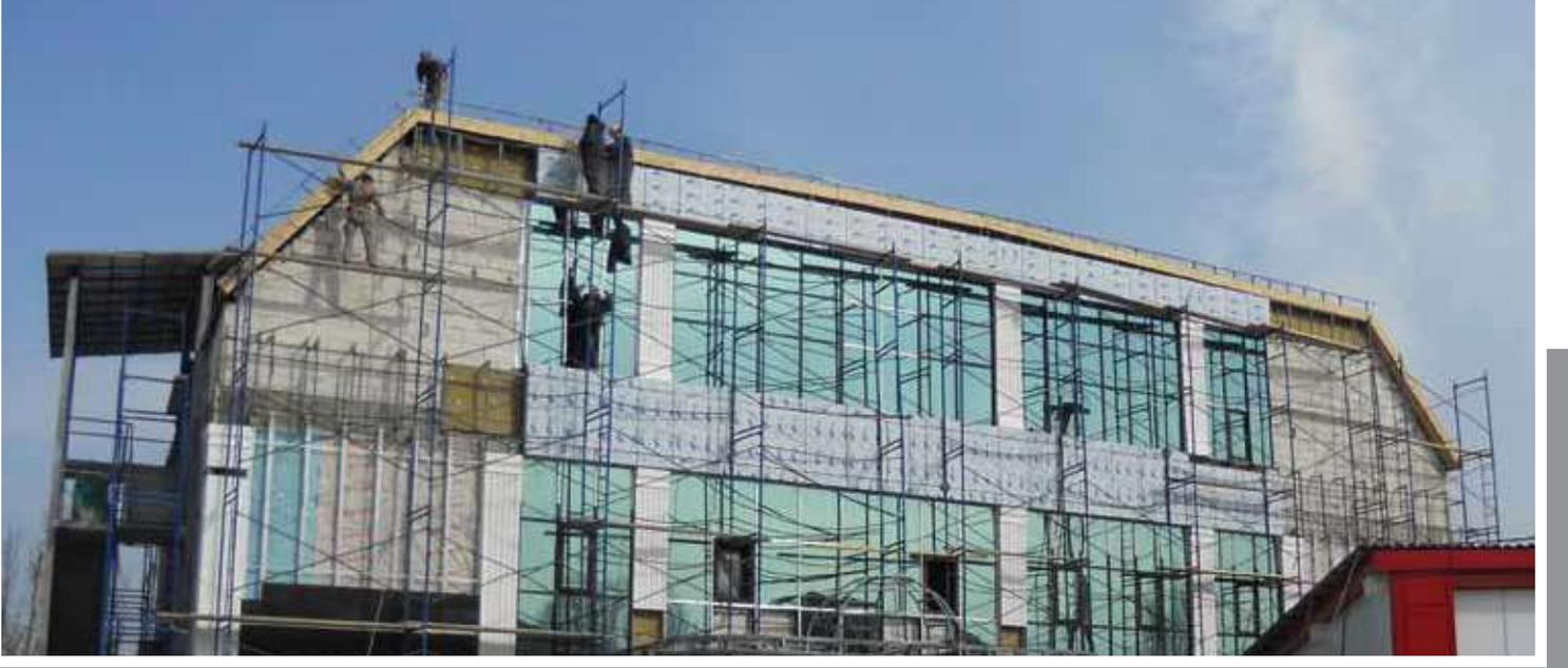
■ 3 katlı yapının 2 katı betonarme üst katı çelik olarak yapılmıştır. Matbaa ve yayınevi bir arada düşünülen yapı cam cephe ile kaplanmıştır. Toplam inşaat alanı 1.500 m<sup>2</sup>'dir.
